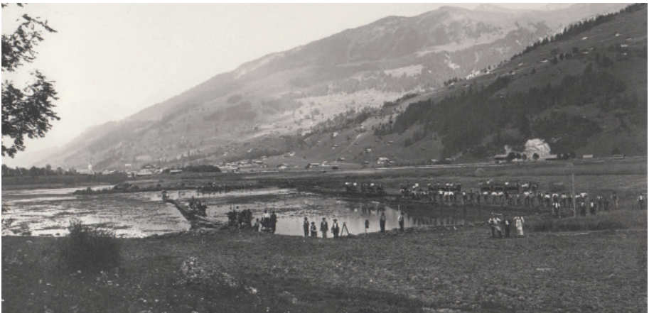
Der Bau Lenkersee, zur Entsumpfung des Landwirtschaftslandes, wurde 1910 bis 1916 in reiner Handarbeit ausgeführt. Rechts auf dem Bild der helle Flecken ist ein grosser Steinbruch aus welchem die Steine zur Verbauung und Begradigung der Simme abgebaut und abtransportiert wurden.
