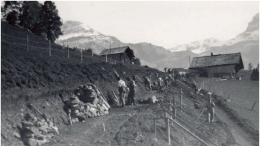
Bau der ersten Strassenetappe Bühlberg bis zum Tannenbühl um 1945. Alle Arbeiten wurden von Hand ausgeführt, hier auf der Höhe
